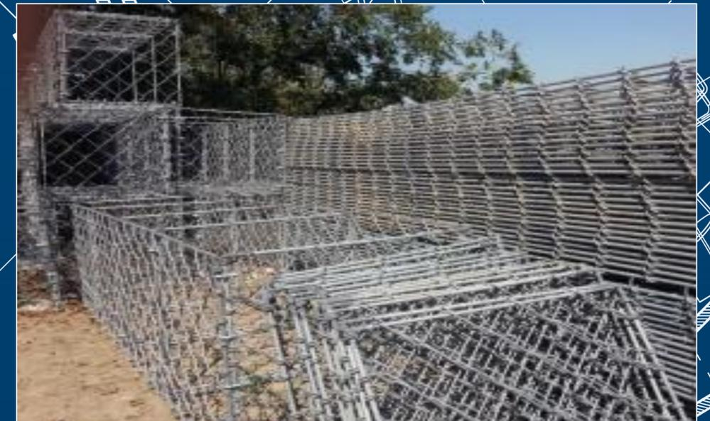
Нормой 30-08-047-04 предусмотрена загрузка габионных конструкций, установленных в проектное положение, при помощи экскаватора. Нормой 30-08-047-05 предусмотрена установка в проектное положение заполненных габионных конструкций
