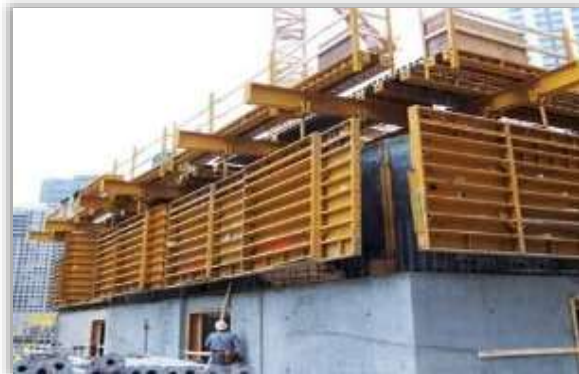
Монтаж и демонтаж опалубки монолитных железобетонных конструкций
