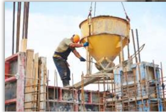
Бетонирование по схеме "кран-бадья"
