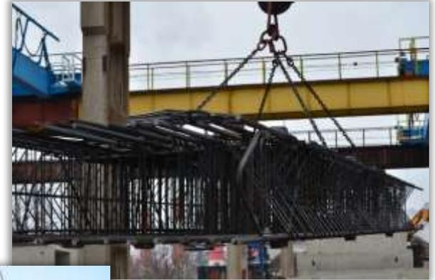
Бетонирование по схеме "кран-бадья"
